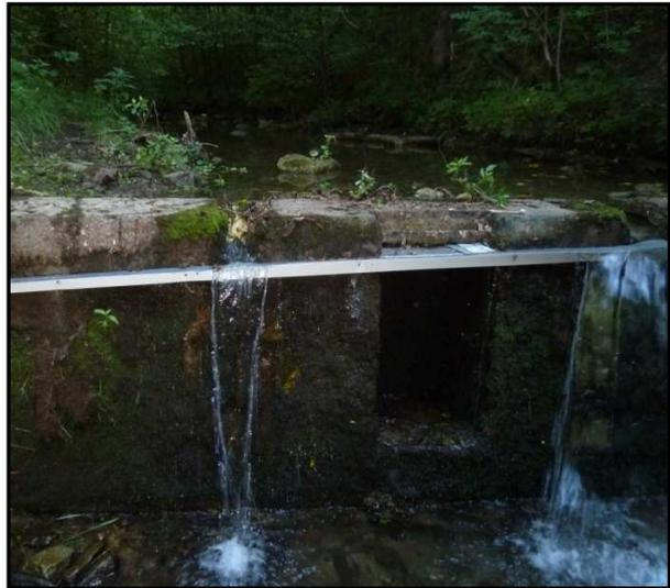
**Photo 30 : Le seuil du moulin équipé d'une cornière en tôle pour éviter que les écrevisses ne montent ; ruisseau de la Foux, septembre 2013.**
