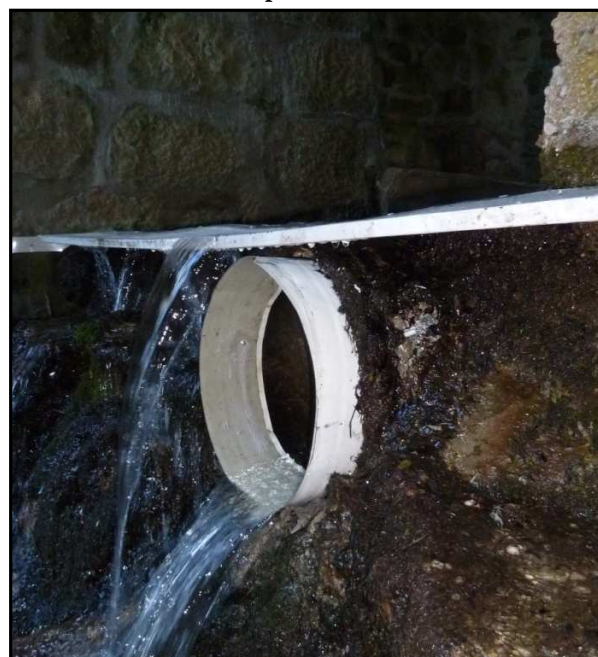
Photo 32 : Détail, vue de profil, des tôles du pont de la route départementale ; ruisseau de la Foux, septembre 2013.
