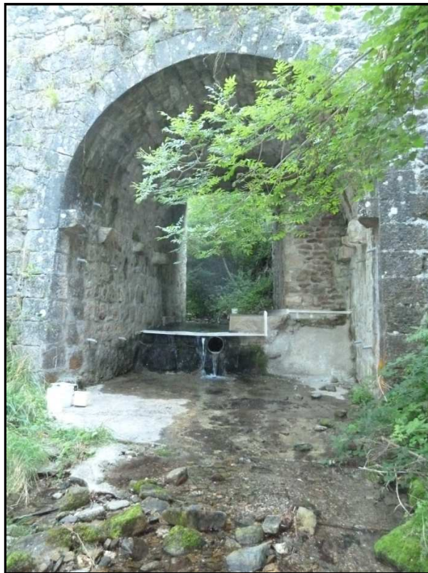
Photo 31 : Le pont de la route départementale avec les tôles "anti-remonté" placées sur le radier ; ruisseau de la Foux, septembre 2013.
