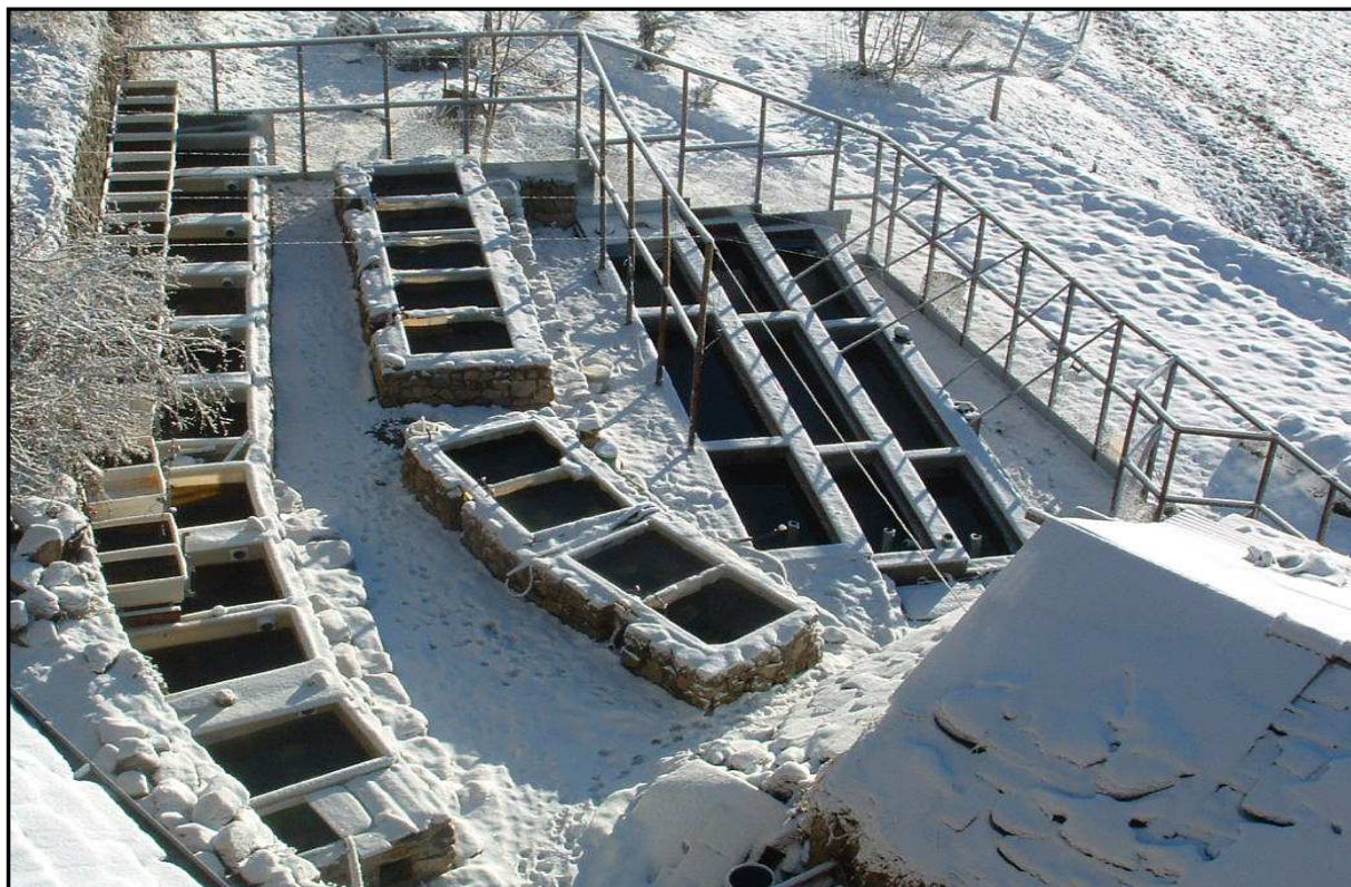
Photo 7 : Vue d'ensemble de la structure expérimentale où ont été menés les essais de stérilisation des mâles P. leniusculus de 2007 à 2012.
